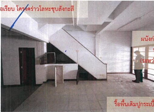
รื้อฝ้าเดิมเปลี่ยนฝ้าเพดานอิพซัมบอร์ด หนา 9 มม. ฉาบรอยต่อเรียบ โครงคร่าวโลหะชุบสังกะสี
