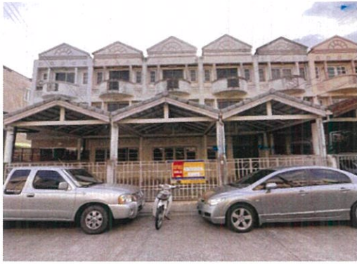
รื้อชุดประตูบานม้วนออก และ ใช้บานประตูไม้เดิม เปลี่ยนชุดอุปกรณ์ลูกบิดชนิดก้านโยก
